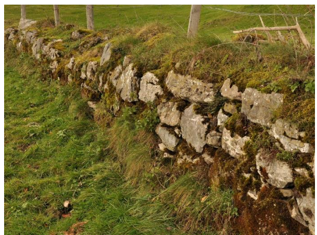
Herkömmliche Trockensteinmauer
