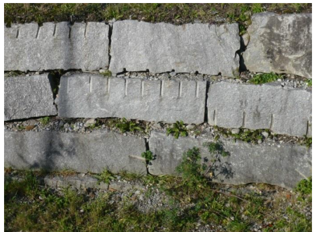
Moderne, aus einheitlichen, industriell hergestellten Steinen errichtete "Trockenmauer"
