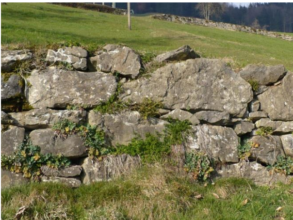
Herkömmliche Trockensteinmauer
