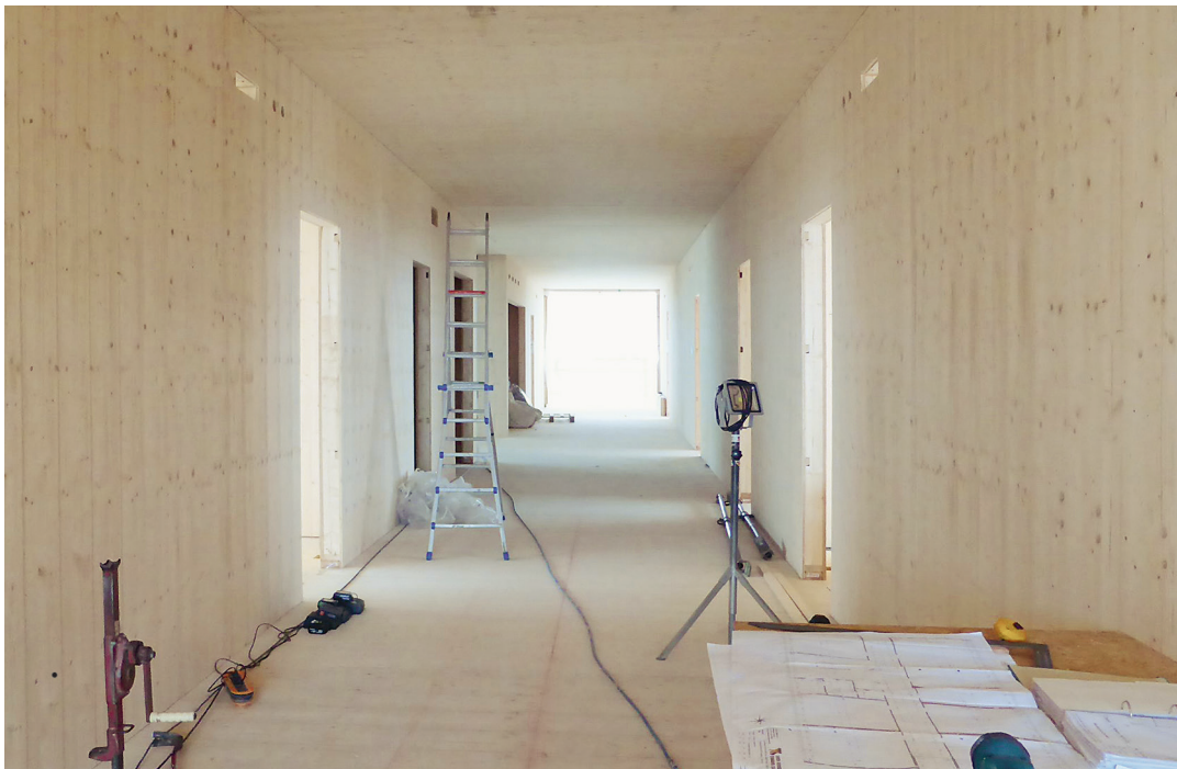
Der Rohbau wurde innerhalb von nur drei Wochen aus vorfabrizierten Holzelementen erstellt.
