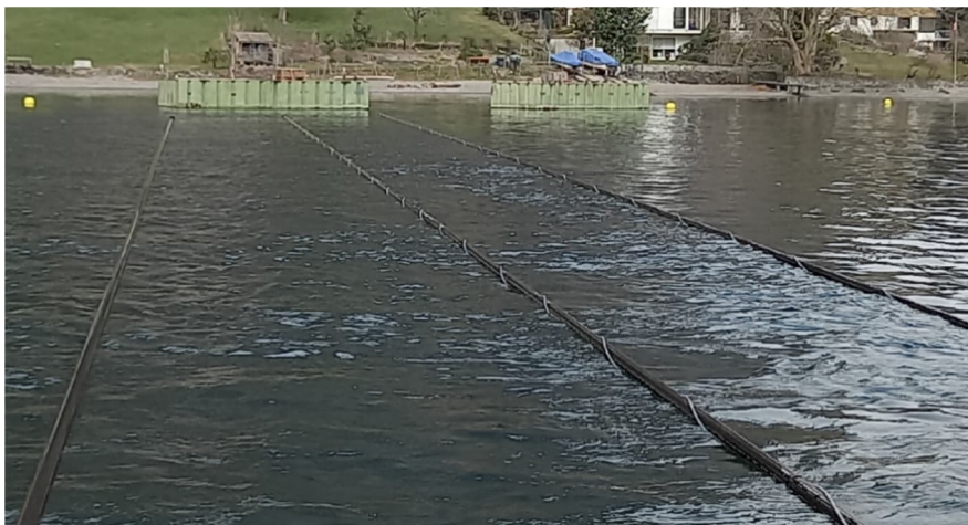
Abbildung 24: HDPE-Leitung mit Drahtseil umwickelt im schwimmenden Rohrlager (Willy Stäubli Ing. AG 2023)
