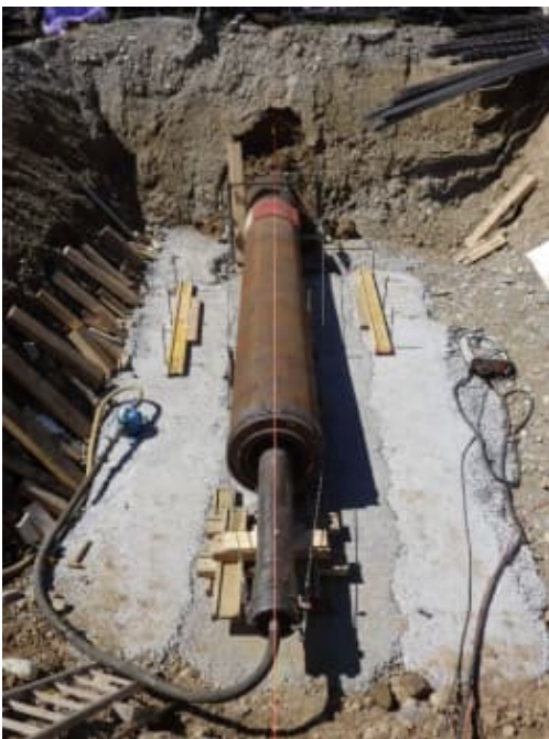
Abbildung 23: Schlagvortrieb beim Bau und mit eingezogenen Rohren
