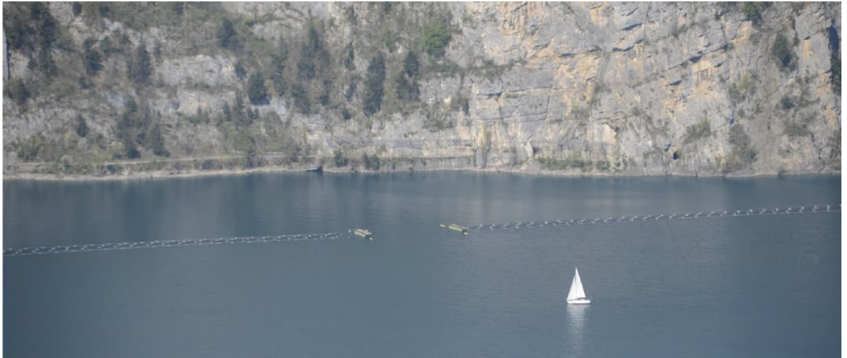
Abbildung 18: Schwimmendes Rohrlager in einem See (Willy Stäubli Ing. AG 2023)
