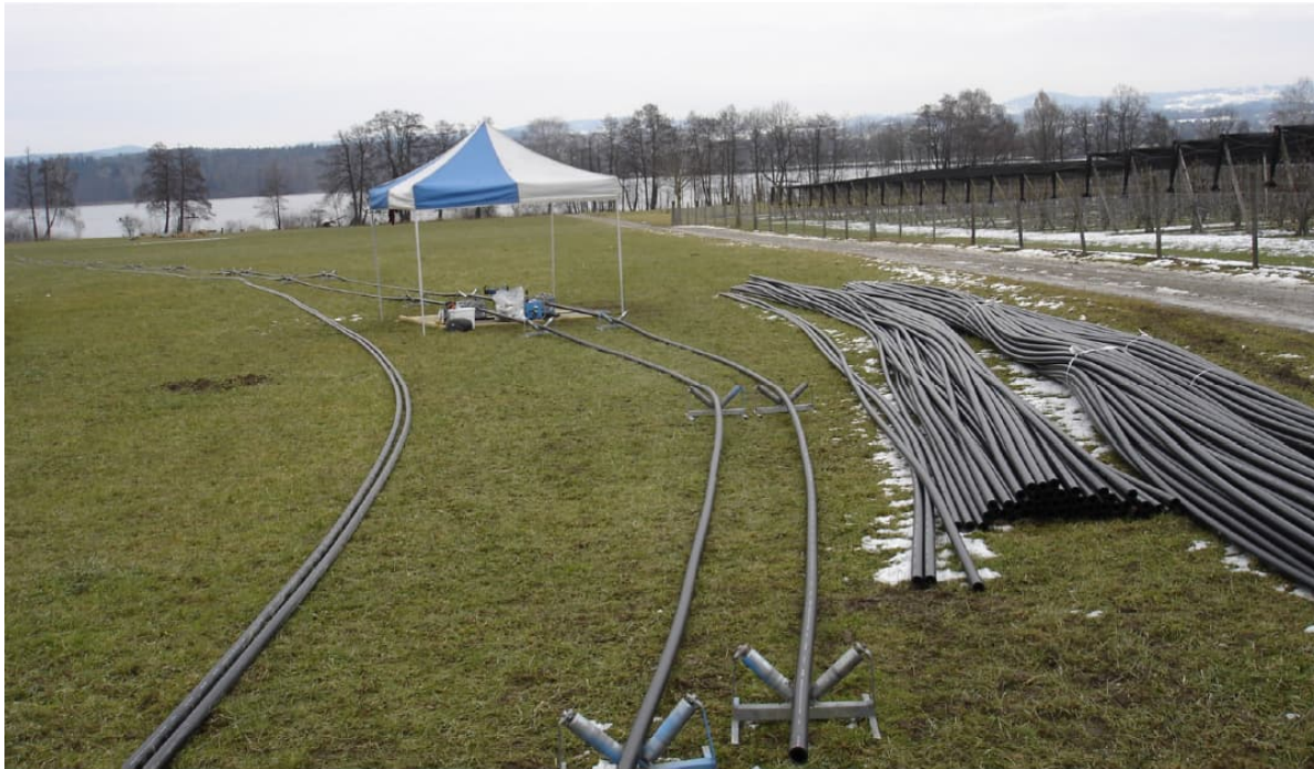
Abbildung 17: Rohrschweisplatz auf einer Wiese am Seeufer (Willy Stäubli Ing. AG 2023)
