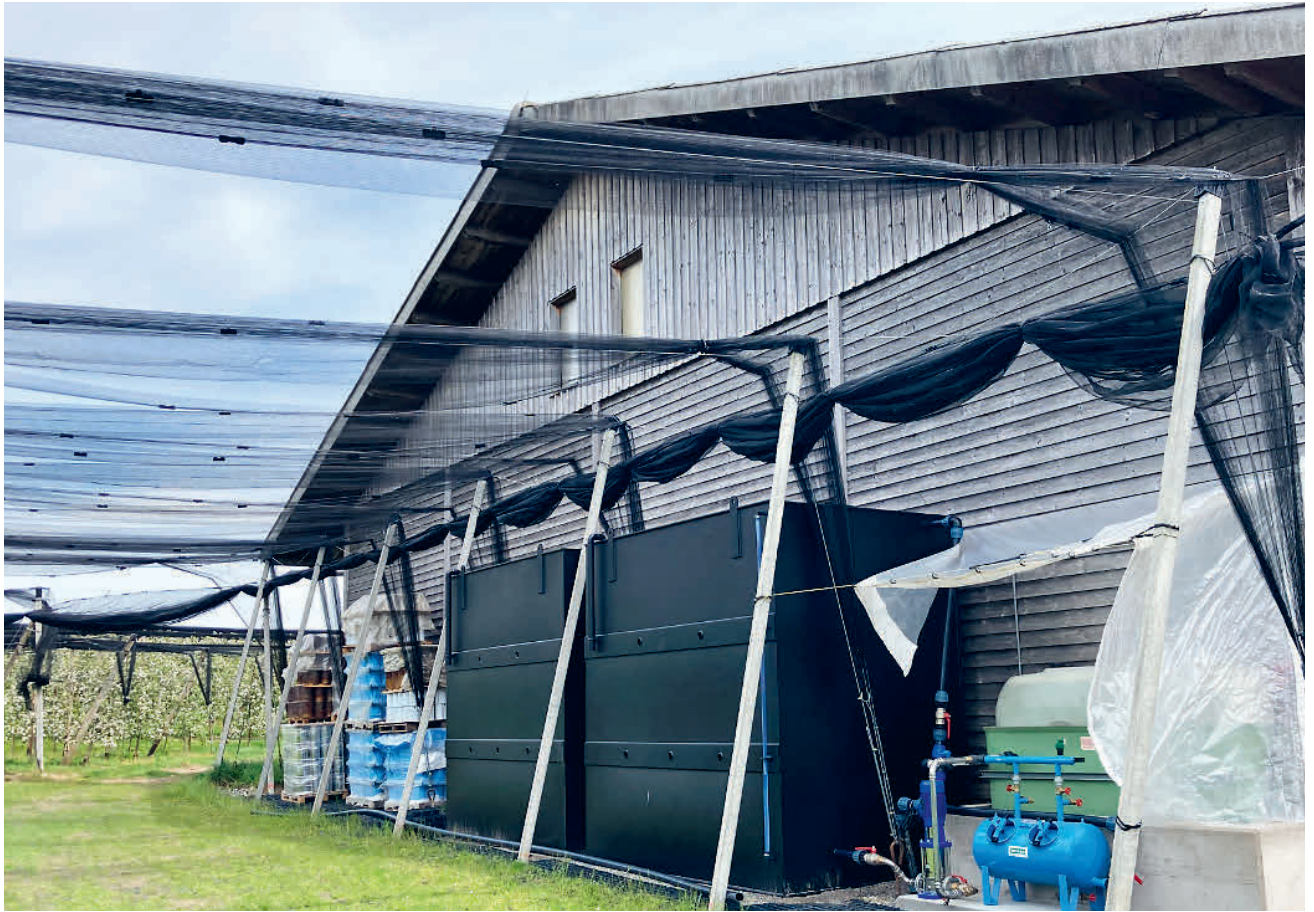
Wenn keine aktive Güllegrube vorhanden ist, lässt sich das Waschwasser als Alternative auch in einem Rückhaltetank (schwarz) sammeln. Über einen Filter (blau) wird das Waschwasser – wie bei diesem Obstproduzenten – der Tröpfchenbewässerung zugeführt.
